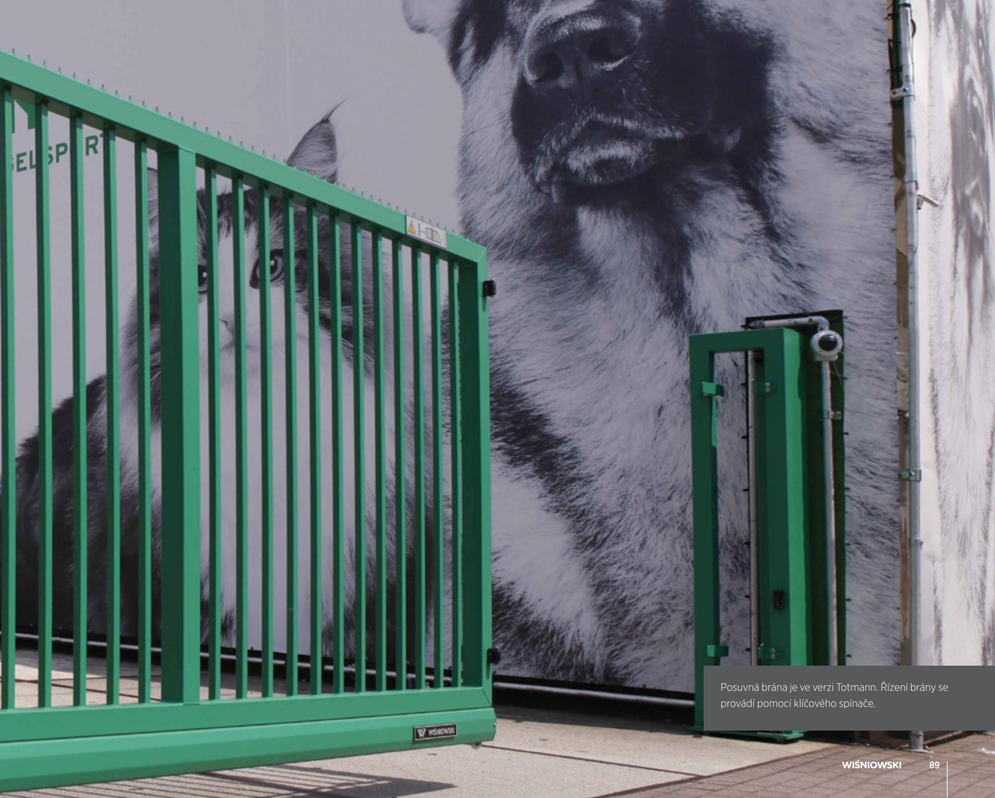
Posuvná brána je ve verzi Totmann. Řízení brány se provádí pomocí klíčového spínače.
